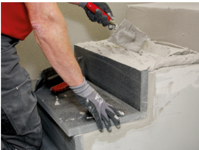
5 Sopro FKM® Silver kann auch in höheren Schichtstärken bis 20 mm verarbeitet werden.
