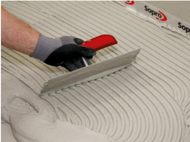
1 Aufziehen der Kontaktschicht und des Kammbetts in der Fließbettkonsistenz.
