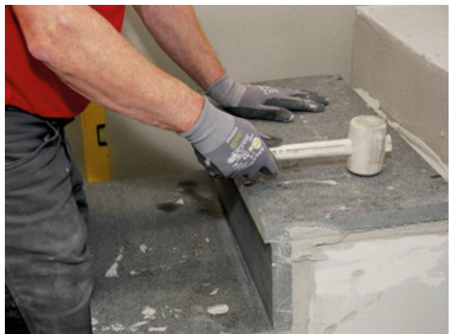
6 Verlegen einer Treppenstufe. Aufgrund der Schnellerhärtung kann eine frühe Belastung erfolgen.
