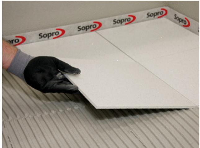
2 Einlegen einer Aggloplatte. Aufgrund der Schnellerhärtung eignet sich Sopro FKM® Silver auch für die Verlegung verformungsempfindlicher Beläge.
