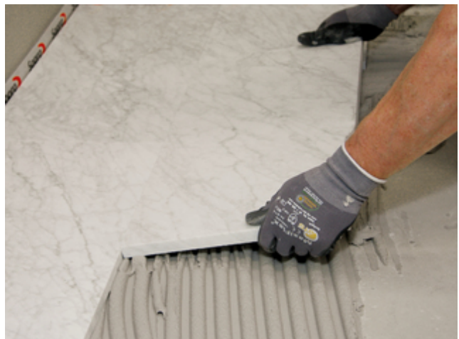
4 Einlegen einer Natursteinplatte. Aufgrund der hellen Farbe eignet sich Sopro FKM® Silver auch für die Verlegung durchscheinender Materialien.
