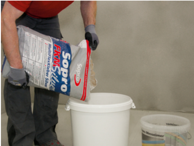
1 Anrühren von Sopro FKM® Silver in der gewünschten Konsistenz für die Verlegung im Dünn-, Fließ- oder Mittelbett bzw. zum Spachteln.
