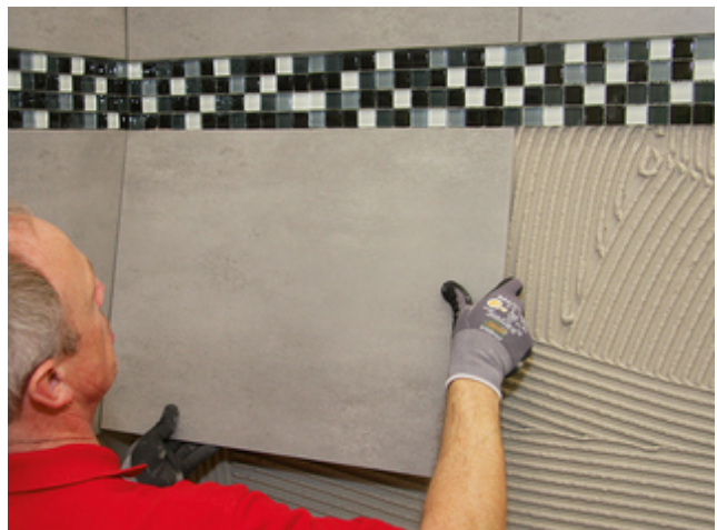
4 Sehr gute Standfestigkeit zum Ansetzen von großformatigem Feinsteinzeug.
