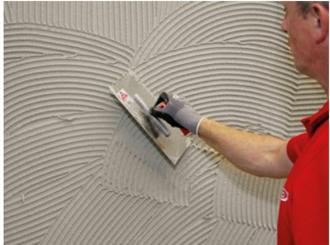
2 Aufziehen der Kontaktschicht und des Kammbetts in der Dünnbettkonsistenz.
