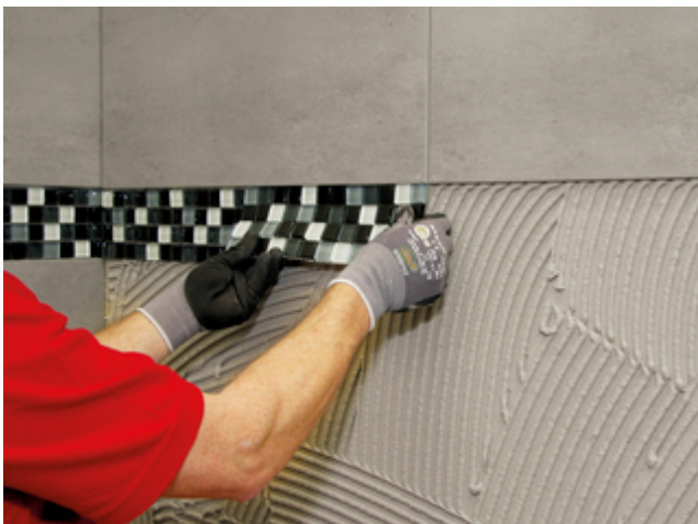
3 steinzeug. Einlegen von Glasmosaik in das vorbereitete Kleberbett.
