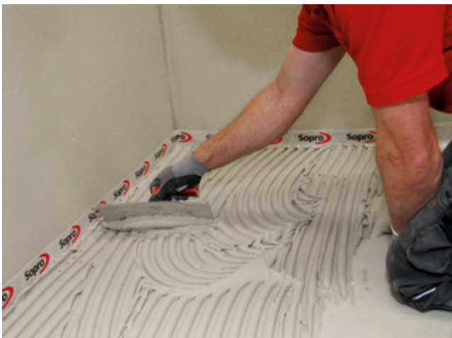
3 Zur Mittelbettverlegung Sopro FKM® Silver in der Mittelbettkonsistenz aufziehen.
