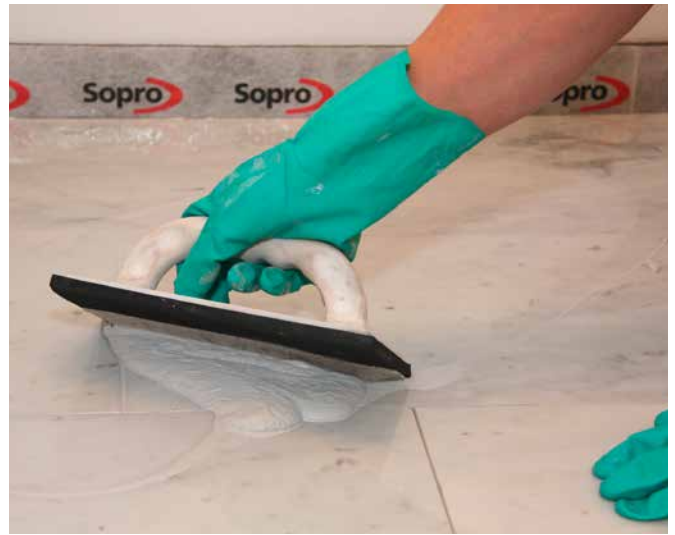
8 Einfugen von Sopro DF 10® in verfärbungsempfindlichen Naturstein.
