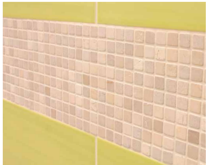
10 Steingut- und Natursteinmosaikflächen verfugt mit Sopro DF 10®.
