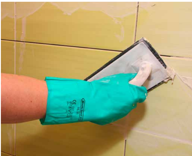
9 Einfugen von Sopro DF 10® in Steingutfliesen.
